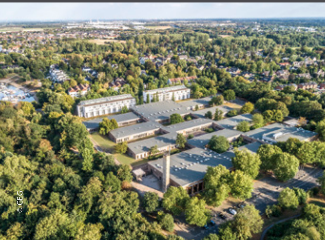
Investition in Infrastrukturimmobilien: zum Beispiel das Schulungszentrum der Polizei Nordrhein-Westfalen in Neuss
